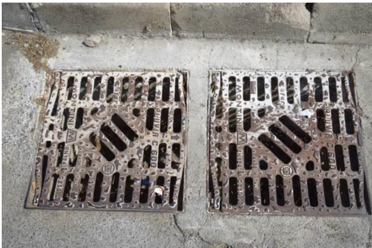
Figura 22- Dettaglio relativo ai tombini della raccolta delle acque bianche.
