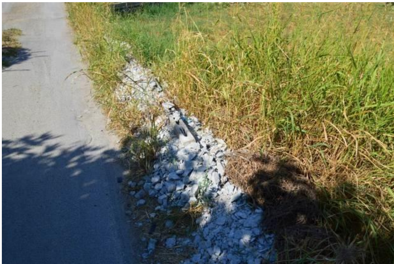
Figura 11. Materiale derivanti da lavorazioni edili utilizzati come materiale di riporto nella stradina perimetrale all'area interessata dalla lottizzazione.
