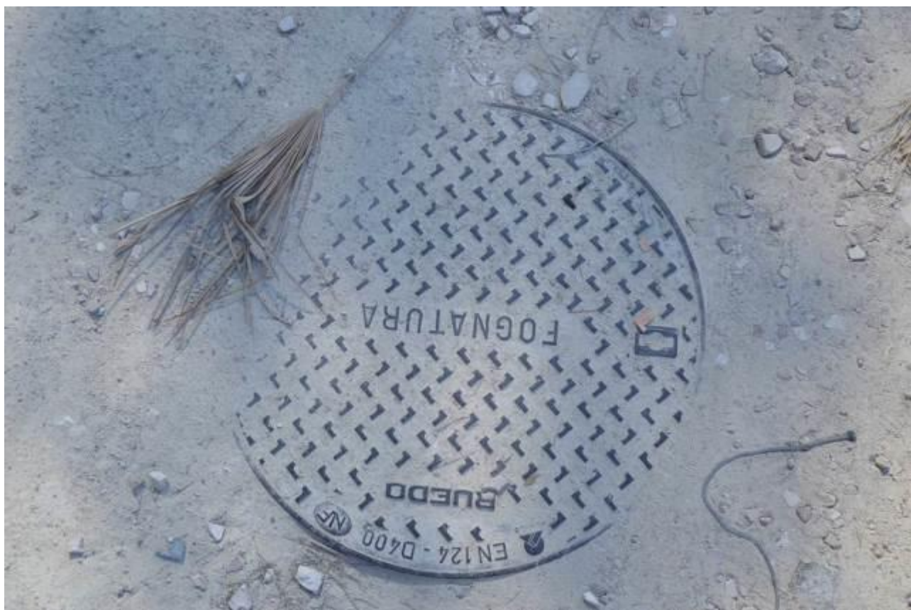
Figura 23- Dettaglio relativo ai tombini della fogna presente sul lato sud dell'area
