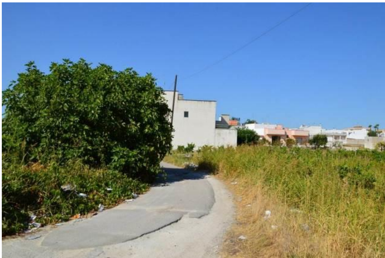
Figura 16. Strada caratterizzata da una curva cieca.
