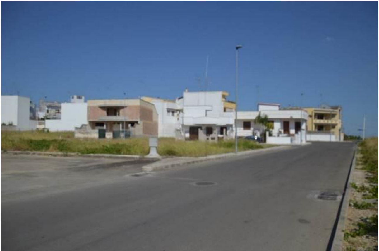
Figura 21- Presenza di tombini della fogna e acque bianche sul lato nord dell’area.
