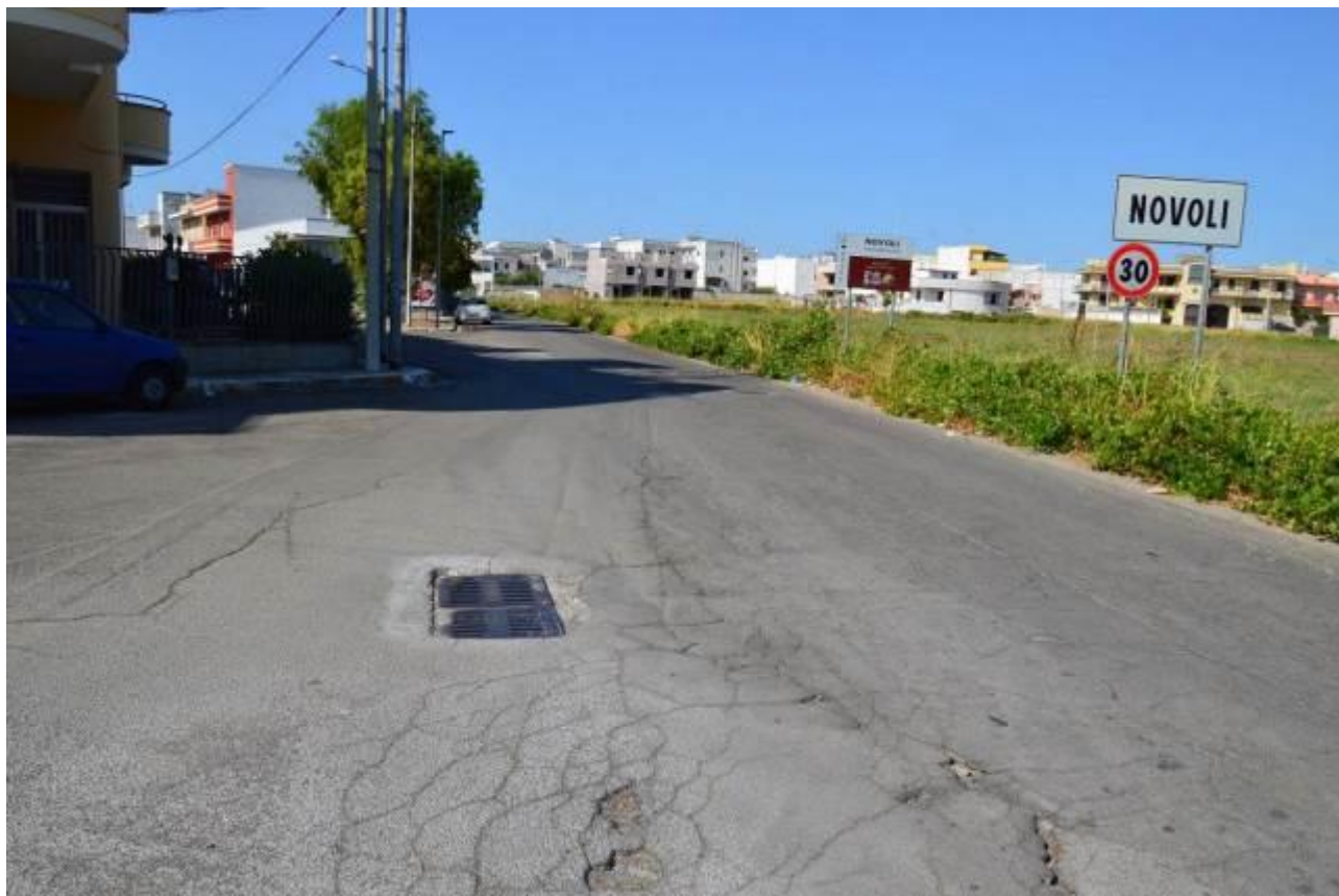
Figura 24- Presenza di tombini delle acque bianche sul lato ovest dell'area.
